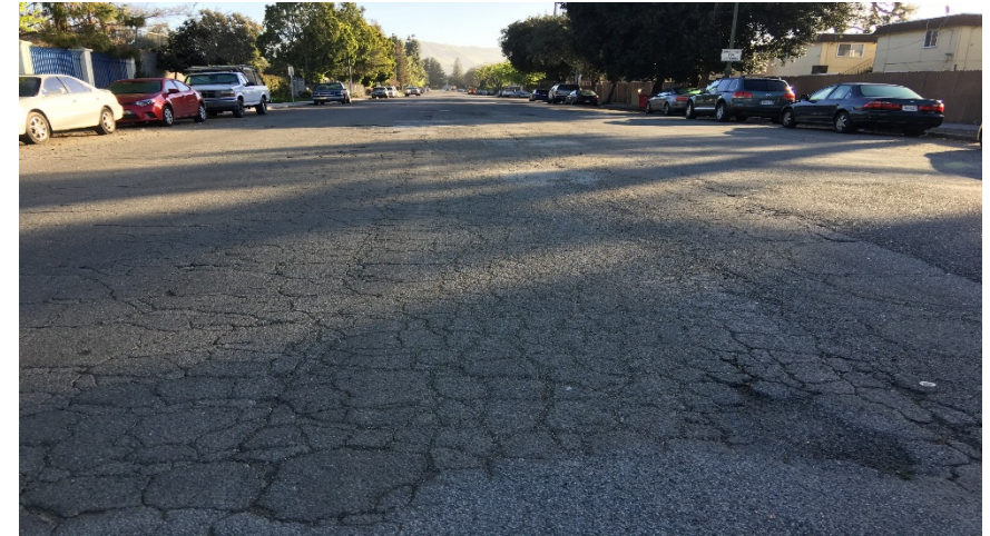
Las Plumas Ave: PCI 37, 1991 Chip Seal
